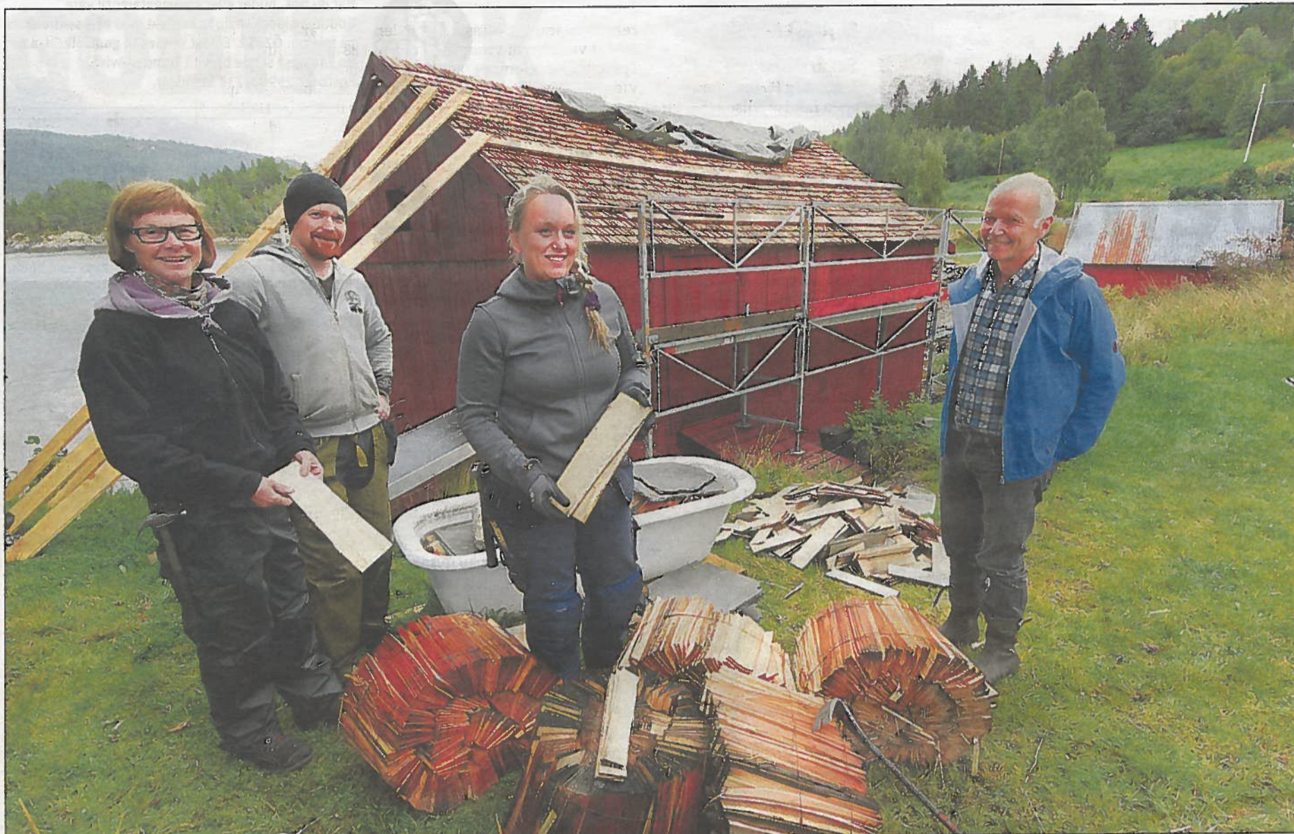
TILBAKEFØRT: Byggmester Sissel Norum, tømrer Pål Melgård, byggmester Ellen Giskås og eier Asbjørn Karlsen foran nauset ved Ernst Karlsen landhandel som nå blir restaurert med nytt spontak.
