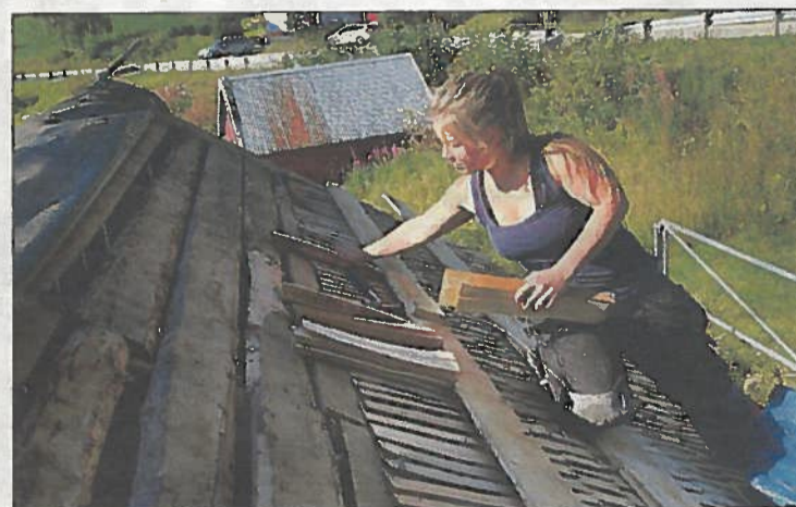
LEGGING: Sara Margrete Gilberg Nyjordet fra Steinkjer, som ble kåret til Årets lærling i Nord-Trøndelag 2012, var med på legging av spontaket tidligere i sommer.
